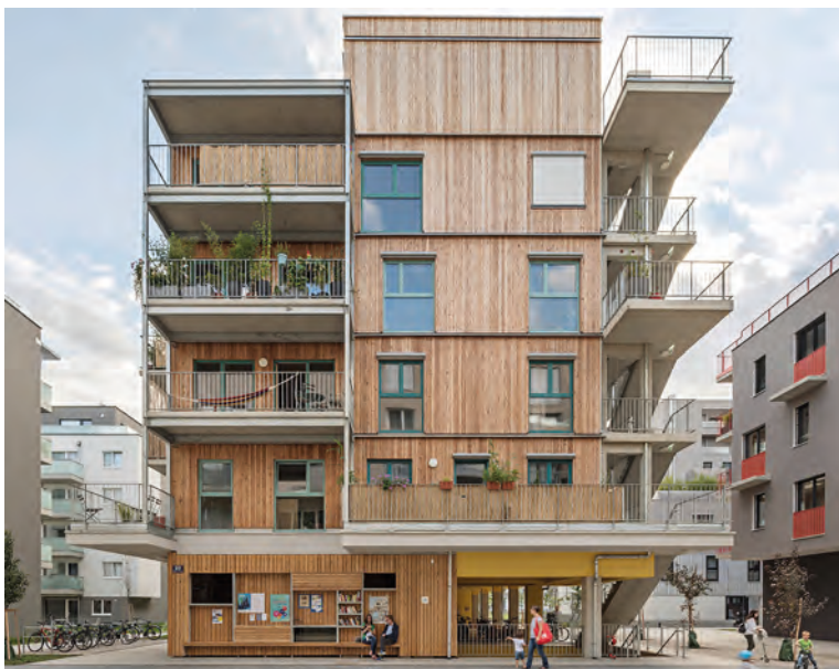
Die Baugruppe Gleis 21 will in Wien das Dorf in die Stadt bringen. Die Bewohner leben Gemeinschaft statt urbaner Anonymität. Foto: Hertha Hurnaus.
